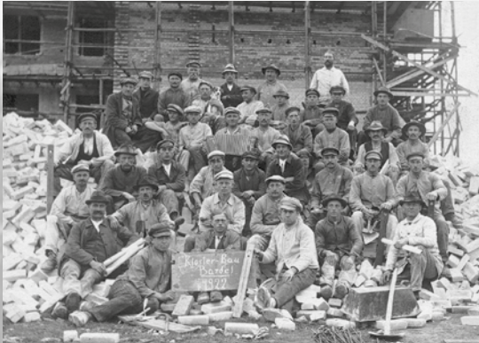
Bauarbeiter beginnen mit dem Bau von Kloster und Schule (um 1922)
