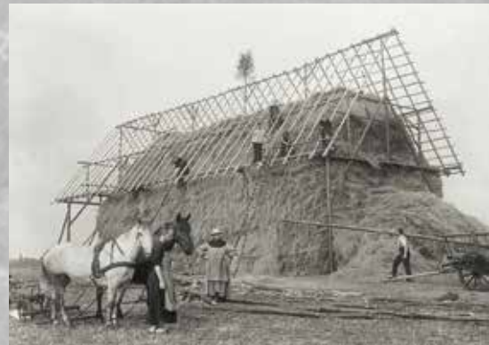
Bau einer Getreidescheune (1936)
