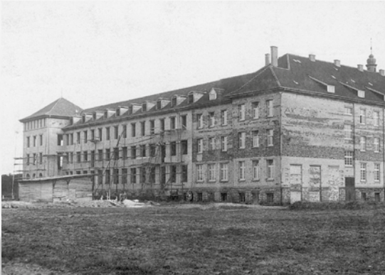
Die Westseite der Schule nach Errichtung des Daches (Ende 1920er Jahre)
